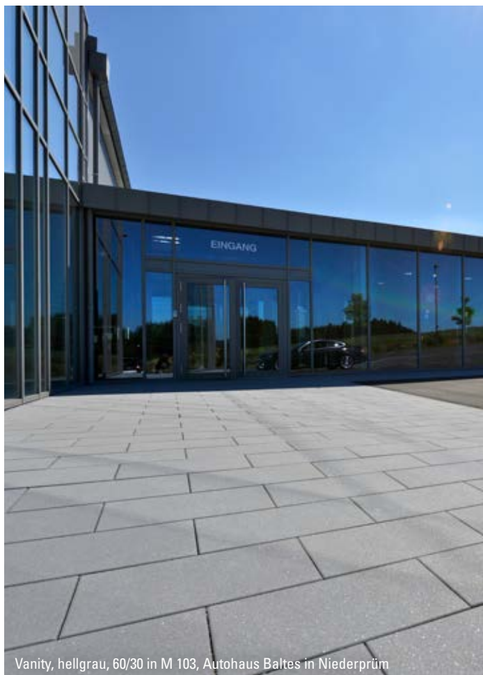
Vanity, hellgrau, Sonderformat 30/15 in M 103, Karlsruher Institut für Technologie in Eggenstein-Leopoldshafen
