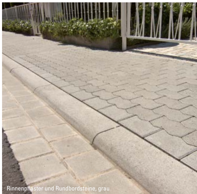
Rinnenpflaster und Rundbordsteine, Sonderoberfläche Granit, wassergestrahlt
