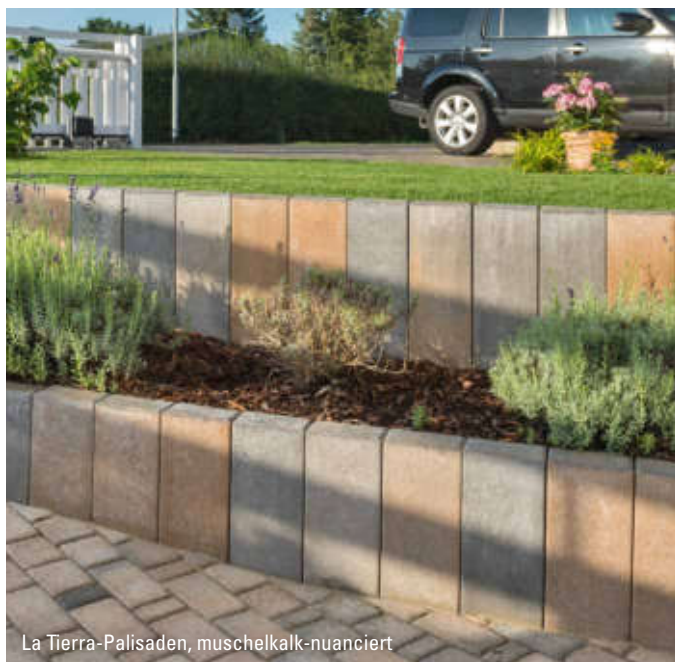
La Tierra-Palisaden und -Stufen, anthrazit, Kindergarten in Kürten
